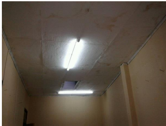
Gambar 6. Pembuatan ventilasi dan pemasangan lampu
