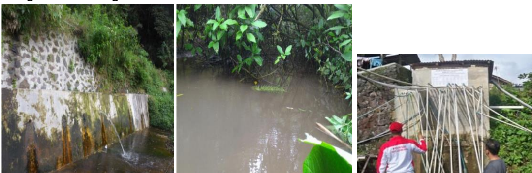
Gambar 3. Contoh Sumber Mata Air Permukaan, Bak Pembagi, dan slang distribusi
