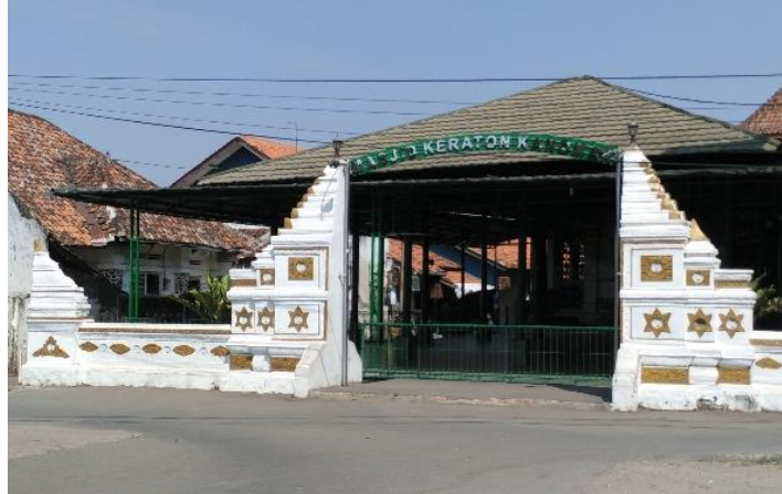
Gambar 4. Bangunan Masjid Keraton Kanoman dari arah Timur
