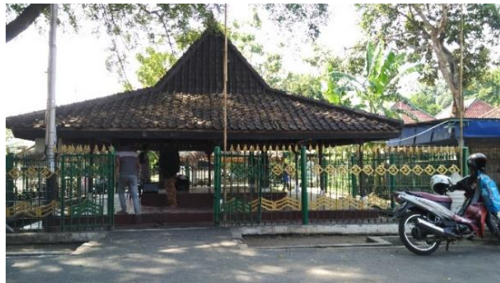
Gambar 2. Bangunan Pancaniti Keraton Kanoman dari arah Barat Sumber : Hasil Grand Tour, 2017
