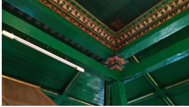
Gambar 7. Bagian langit-langit ruang prabayaksa terdapat hiasan dengan plafond kayu Dengan empat saka guru
