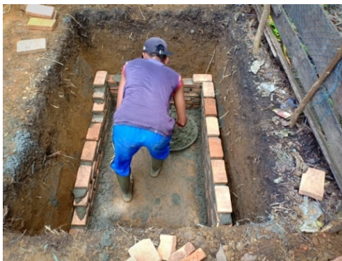
Gambar 7. Pembuatan dinding tangki septik anaerob
