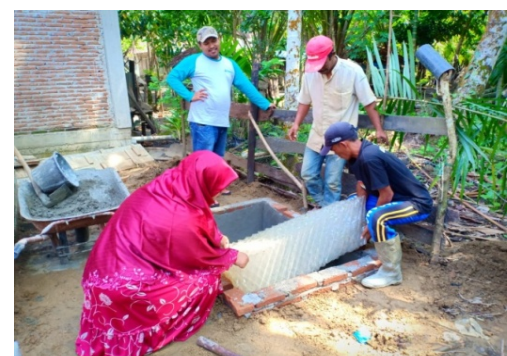
Gambar 10. Pemasukan biofilter buatan pada tangki septik anaerob
