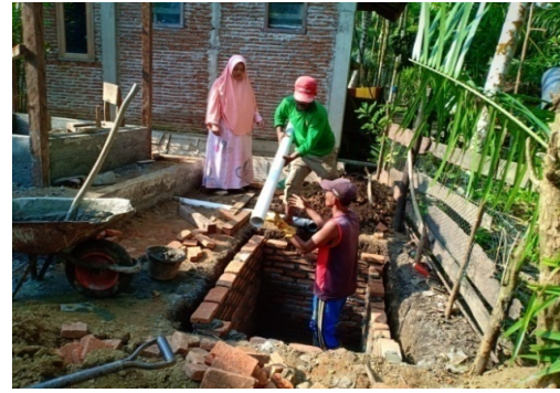
Gambar 8. Pemasangan pipa limbah pada tangki septik anaerob
