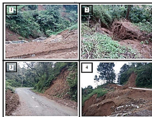
Gambar 1. Daerah Rawan Bencana di Kecamatan Pasirjambu berupa Erosi Tanah di Desa Sugihmukti dengan Tataguna Lahan Semak Belukar, Kelerengan Curam, Tidak ada Saluran Drainage. ( http://repository.unpas.ac.id/15522/3/BAB%20III%20ANGGA.pdf )
